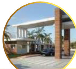
PÓRTO DE INGRESO
