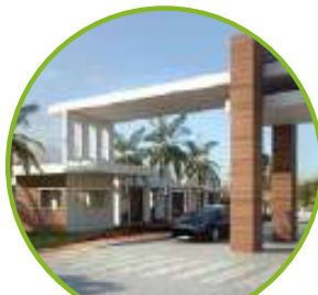
PORTICO DE INGRESO
